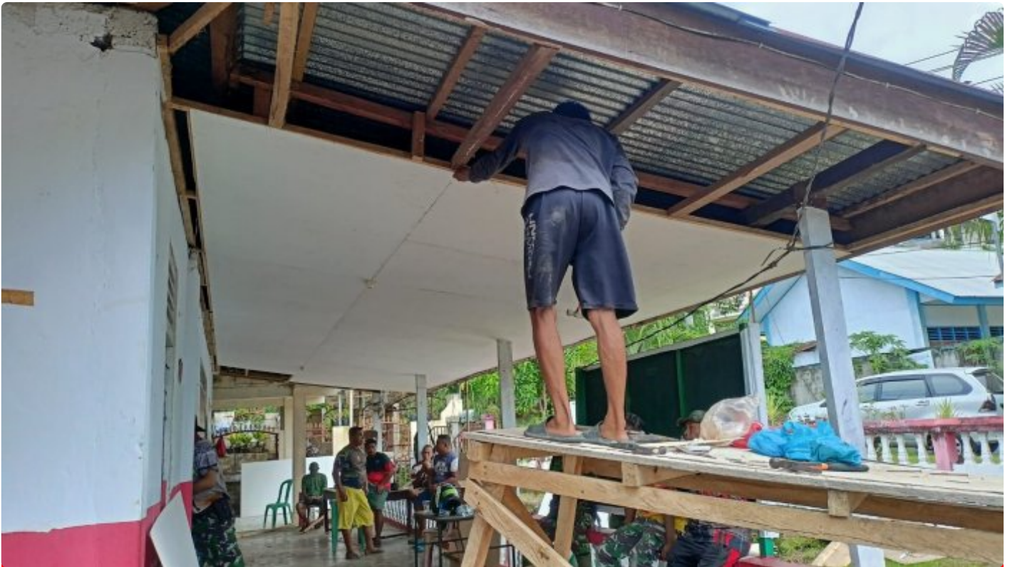
Satgas TMMD Renovasi Kantor Kelurahan Tandurusa
