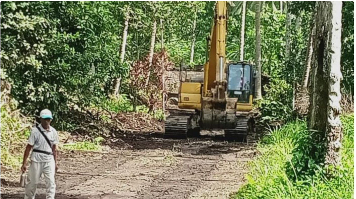
Pekerjaan Jalan Industri Pertanian pada TMMD Ke-116 di Kelurahan Tandurusa
