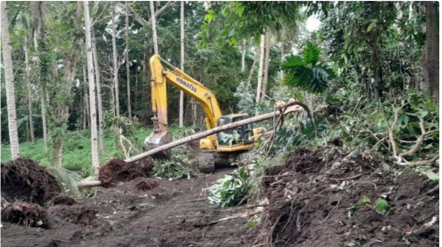
Pekerjaan Infrastruktur Pembukaan Jalan di TMMD Tandurusa
