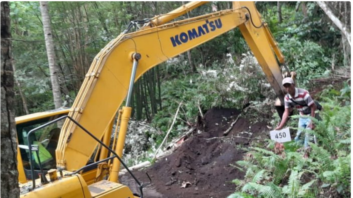
TMMMD Ke-116, Kebut Kerja pembuksan akses Jalan
