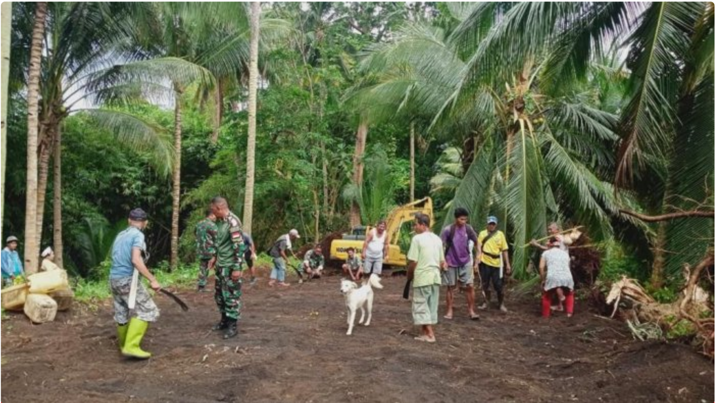
Warga berbaur bersama Satgas TNND Ke-116 Kodim 1310 Bitung dalam kerja Pembangunan Jalan Pertanian
