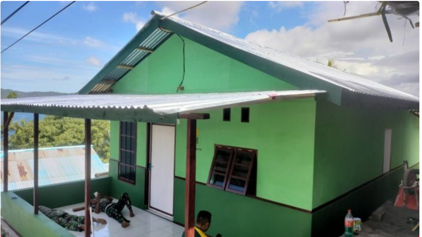
Renovasi RTLH TMMD Ke-116 Kodim 1310 Bitung
